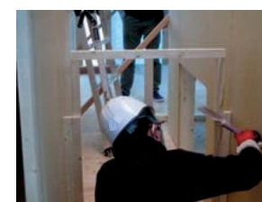
① 支持パネル設置
